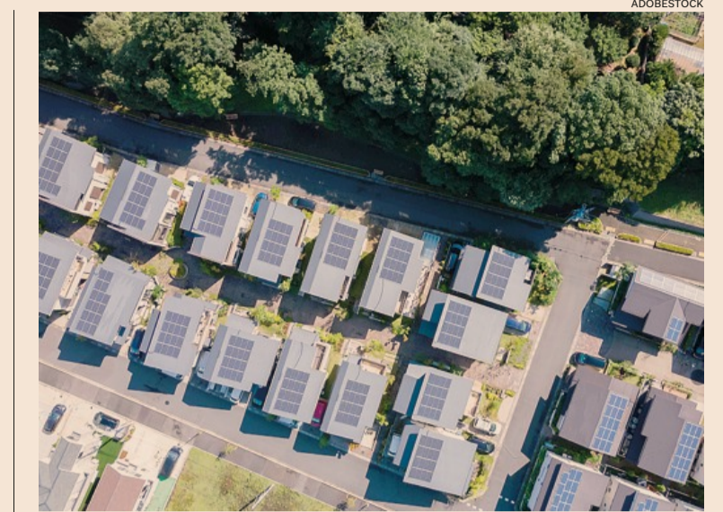
Comunità energetiche. Nel prossimo futuro potranno mettere a fattor comune l'alimentazione con energie rinnovabili di interi quartieri
