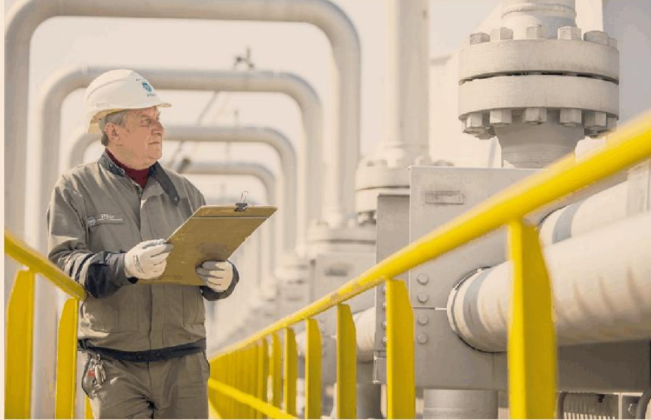
Stoccaggi. L'impianto Stogit (gruppo Snam) di Bordolano tra le province di Cremona e Brescia
